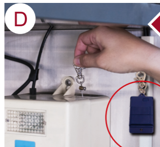
D 停電時可手動拉空檔或遙控切換空檔裝置
